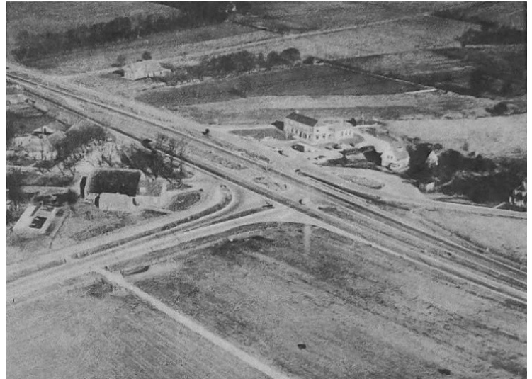
omstreeks 1963 na aanleg van de autowegen
